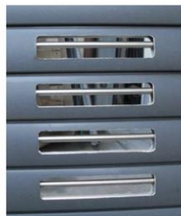
tondino acciaio inox nelle lamelle
