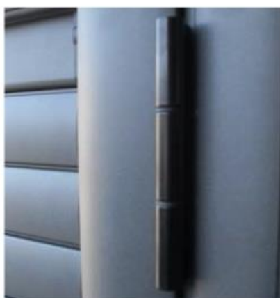
cerniere anti-sfilamento
